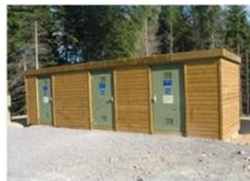
Poste de livraison
