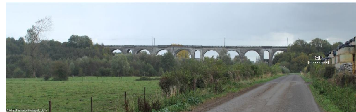
Figure 19 : En sortie Sud du Cateau-Cambrésis depuis la D267 (source : ATER Environnement, 2017)
