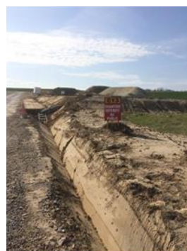
Tranchée pour la pose de câbles
